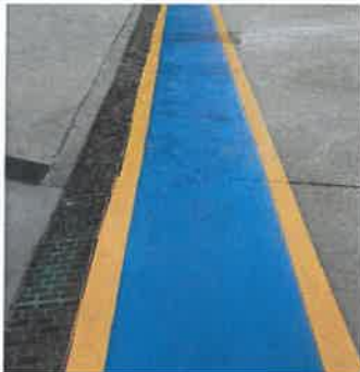
รูปที่ 2-8 ตะแกรงดักกมูลฝอยบริเวณรางระบายน้ำฝน
