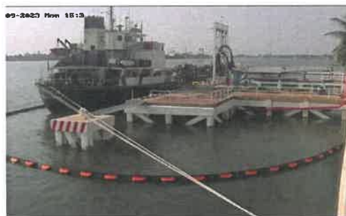
รูปที่ 2-2 โครงการล้อมบูมทุกครั้งในการขนถ่ายน้ำมัน
