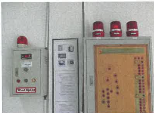
รูปที่ 2-19 ระบบเตือนภัยเมื่อมีความผิดปกติที่ถังเก็บกาก
