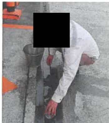
รูปที่ 2-34 การทำความสะอาดบริเวณรางระบายน้ำฝน
