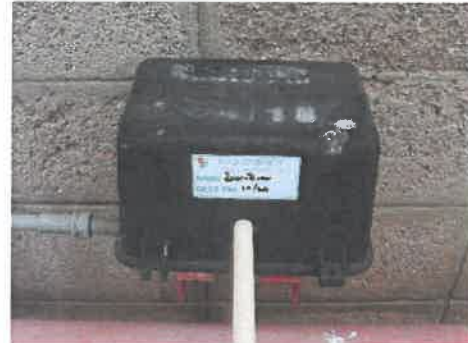
รูปที่ 2-11 ปุ่มสำหรับต่อเครื่องเป่าอากาศในบ่อบำบัด เพิ่มอัตราการลอยตัวของอากาศ
